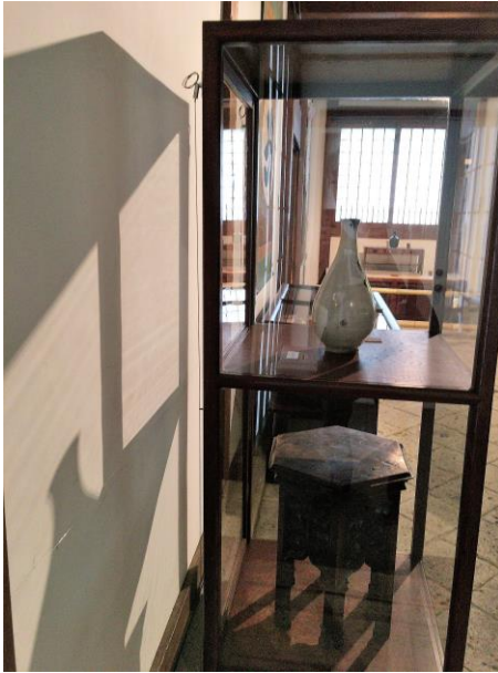
景観的にレールを上端に取り付けたくないとの理由で、視界に入らない下端にレールを取付、ワイヤーを棚に沿って下から上に向かって設置。棚上部に家具ストッパーを固定
