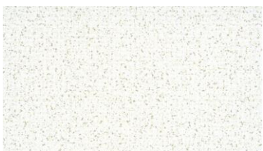
クロスが張られた【石膏ボード】
