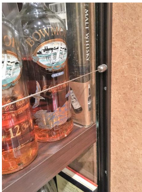
レールからワイヤーを張り出し、棚に沿って、ワイヤーを設置する
