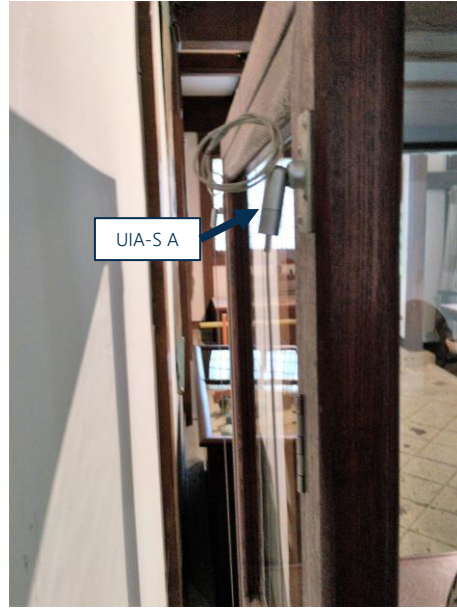
景観的にレールを上端に取り付けたくないとの理由で、視界に入らない下端にレールを取付、ワイヤーを棚に沿って下から上に向かって設置。棚上部に家具ストッパーを固定
