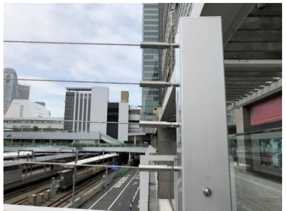
JR某駅南口ご線橋
