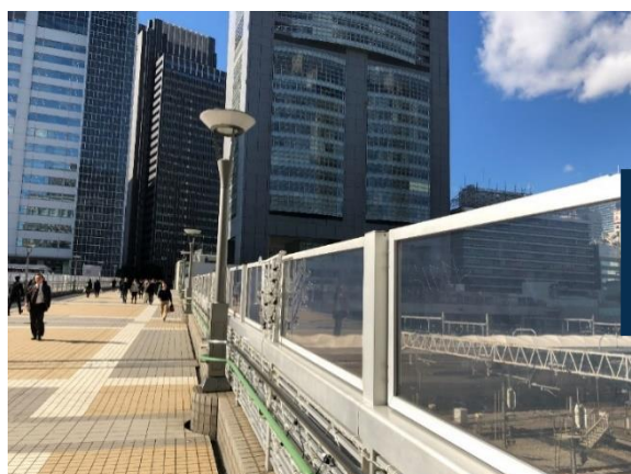
施工前_JR某駅南口ご線橋
