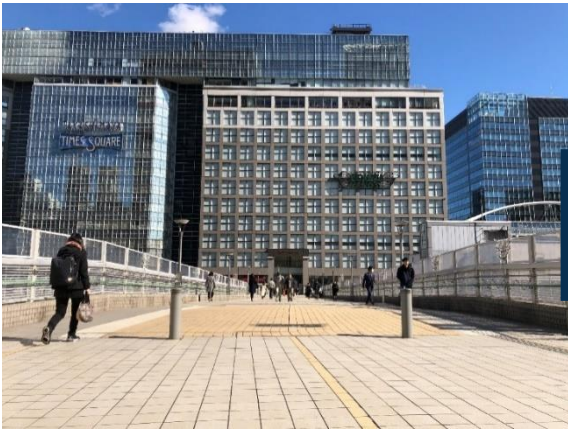
施工前_JR某駅南口こ線橋
