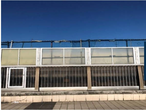
施工前_JR某駅自由通路
