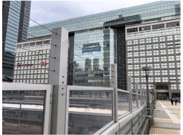
JR某駅南口ご線橋
