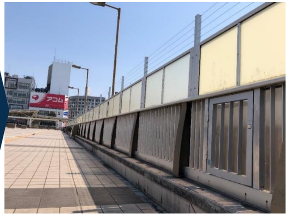
施工後_JR某駅自由通路
