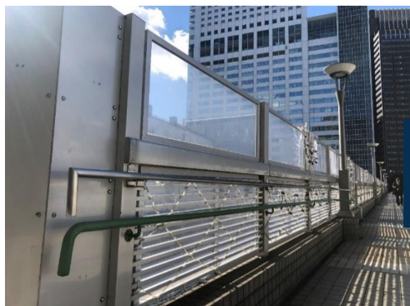
施工前_JR某駅南口ご線橋
