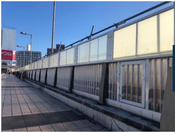
施工前_JR某駅自由通路
