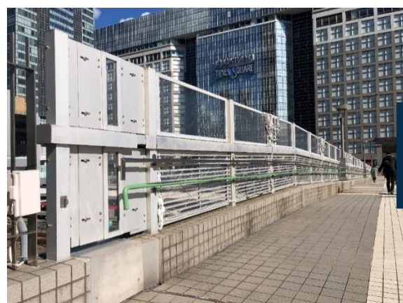
施工前_JR某駅南口ご線橋
