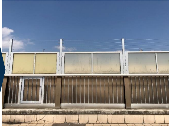
施工後_JR某駅自由通路
