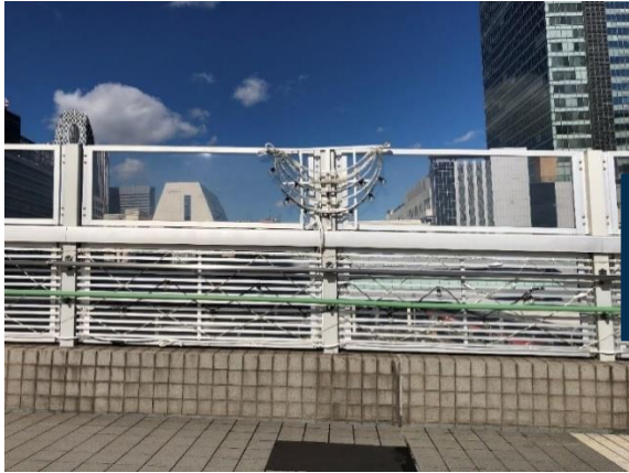
施工前_JR某駅南口ご線橋
