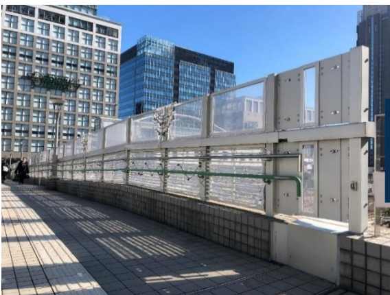
施工前_JR某駅南口こ線橋
