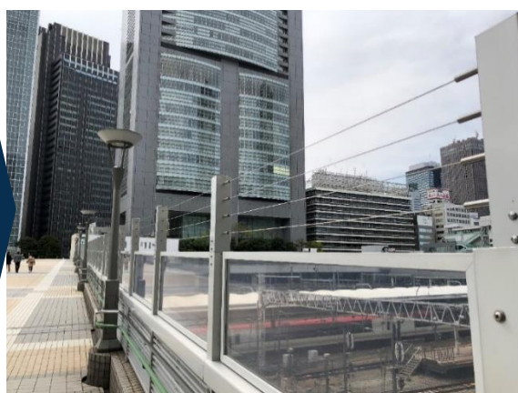
施工後_JR某駅南口ご線橋
