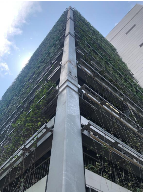
スパイラルワイヤーセットをクロス状に張る事で景観性が良く、風圧による植栽の剥がれ防止にも繋がっています
