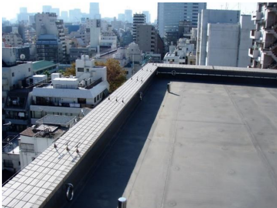
マンション屋上パラペット
