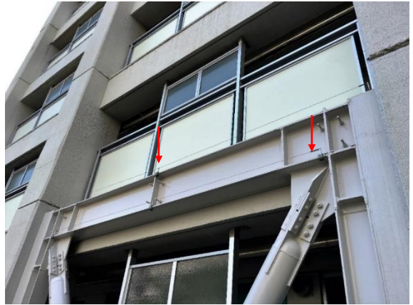
都営住宅 耐震改修工事 制震ダンパーによる制振工法のH後部取付
