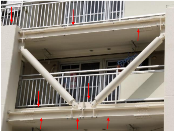
都営住宅 耐震改修工事 制震ダンパーによる制振工法のH後部取付
