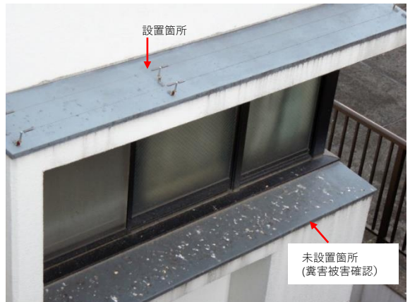
マンション開口庇部
