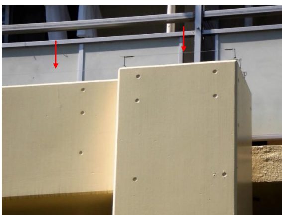
都営住宅 耐震改修工事 (コンクリート打ちタイプ)
