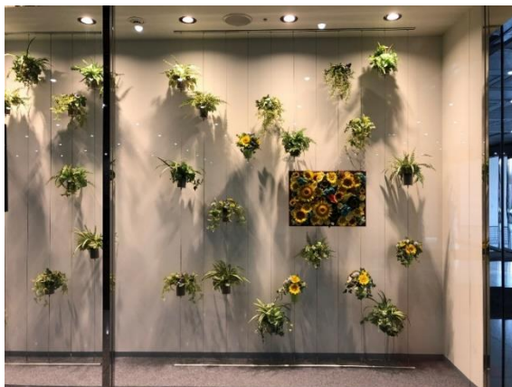
上端下端にインテリア・アンカーレールをビス止めで取り付け。 ハンギングポット以外に、ピクチャレールで使用するハンガーフックを取付け、フラワーディスプレイも同じワイヤー上に吊るしています
