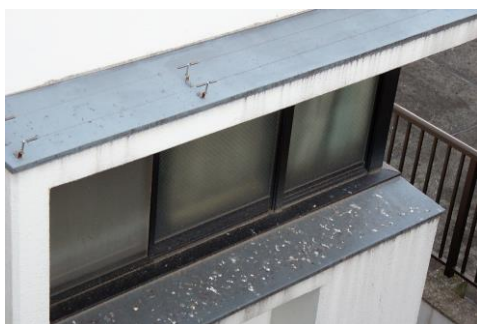
ワイヤー式防鳥システム アルティマ(Uグリッパ)防鳥ワイヤー (PAT)
