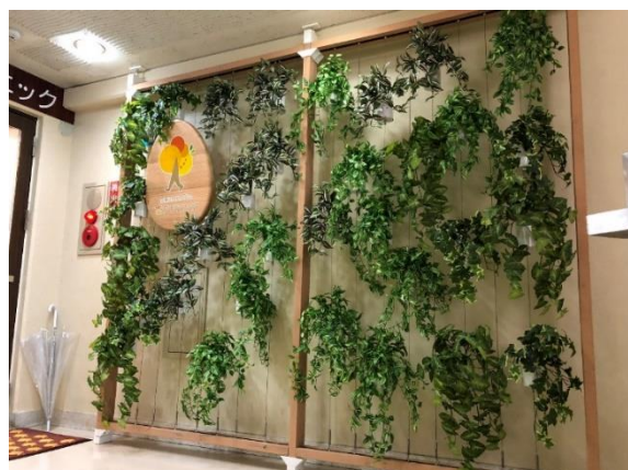
クリニックのエレベーターホールに、空間デザインとして設置。2×4材を使用し、アジャスターで天井部に取付。幅2,400×高さ2,500、ワイヤーピッチ@150
