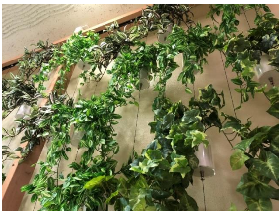
クリニックのエレベーターホールに、空間デザインとして設置。2×4材を使用し、アジャスターで天井部に取付。幅2,400×高さ2,500、ワイヤーピッチ@150
